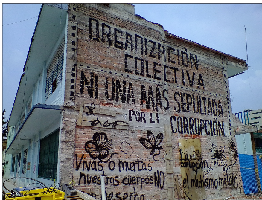
Figura 2: Mensajes en las paredes colindantes al edificio derruido en la calle Chimalpopoca esq. Bolívar, Colonia Obrera.
