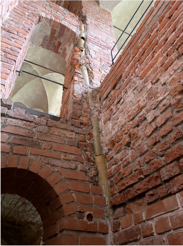
Figure 18. Filarete. Ospedale Maggiore, male ward, terracotta ventilation pipe, 1456–76, Milan. Author's photo.
