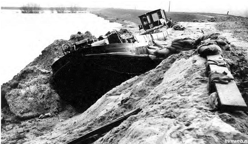
Figure 1.4 Plugging a hole in a dike near Nieuwerkerk aan den IJssel with the boat De Twee Gebroeders . Source: Historical Society of Nieuwerkerk aan den IJssel
