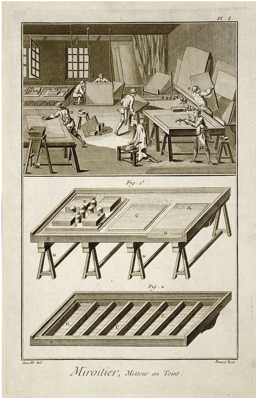
Fig. 22 Robert Bénard, after Jacques-Raymond Laclotte, Miroitier, metteur au teint , engraving, Denis Diderot and Jean le Rond d'Alembert, Encyclopédie ... arts et métiers, art du verre: Fabrication des glaces , Paris, c. 1770, polishing and silvering panes of glass.
